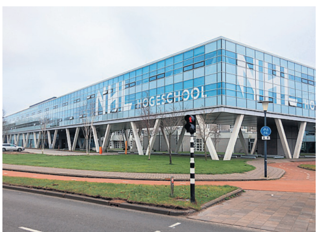
NHL Leeuwarden. De nieuwbouw van Herman Hertzberger omarmt het oude gebouw van Abe Bonnema.
